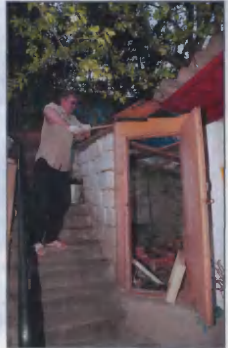
Ломать — не строить! Крышу и часть стены с дверью мы разобрали быстро
