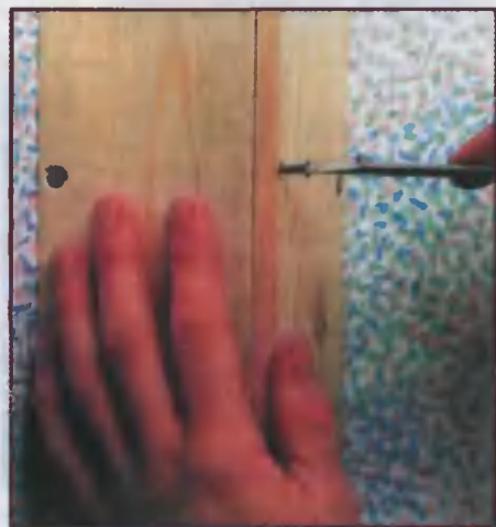
Шурупы ввертывают в заранее просверленные для них отверстия. Кожух потом можно оклеить обоями
