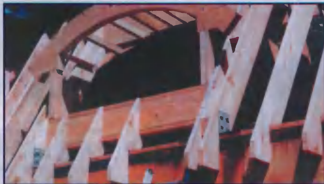
Угловые стропила вставлены под доски площадки. Мансардную крышу венчает платформа из досок 50x200 мм, обвязанных по периметру карнизом из сдвоенных досок 50x250 мм
