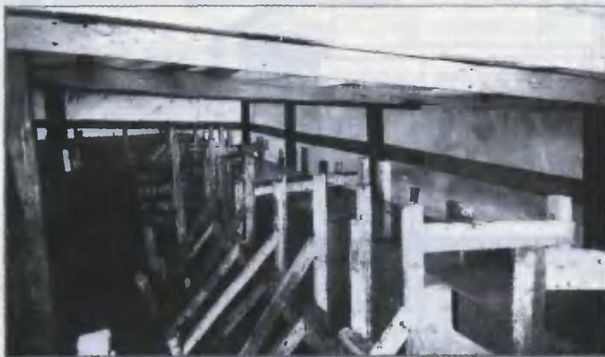
Бетон в теле фундамента набирает прочность в «тепличных» условиях
