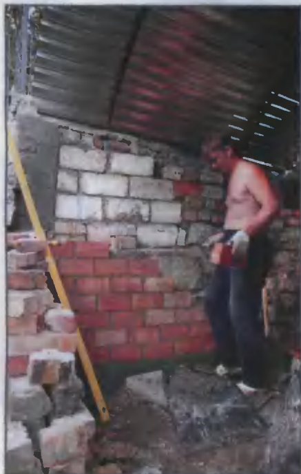
Кирпичом выровняли нижнюю часть стены
