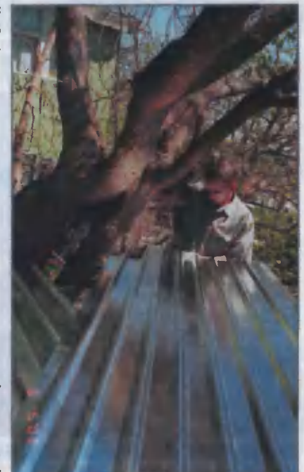
Второй лист, который должен располагаться по верху арочной крыши, пришлось подрезать, чтобы обойти шелковицу
