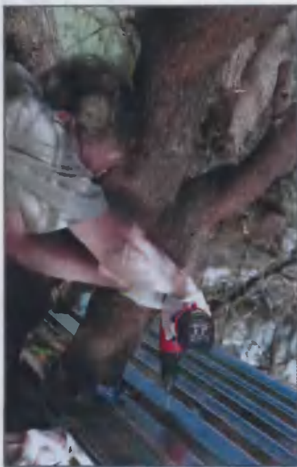
После подгонки верхний лист крепили саморезами, которые вкручивали в «волну» гофролиста
