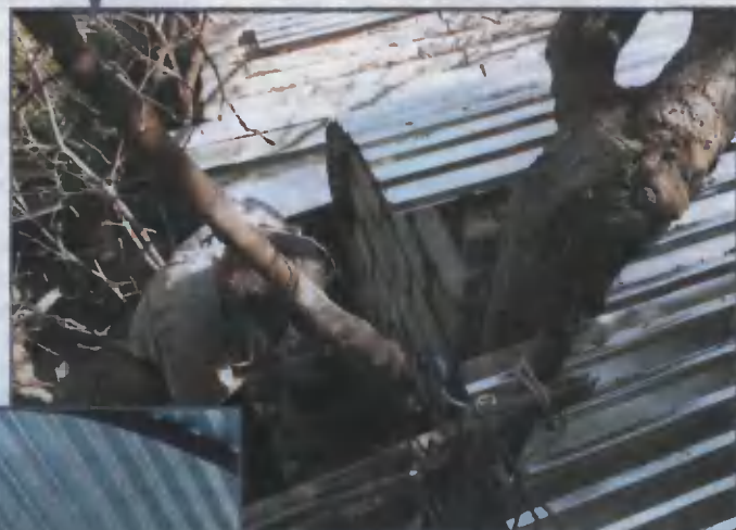
Блоками от старых стен заложили фронтон навеса, оставив пространство для шелковицы
