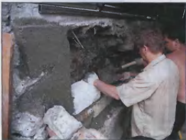
Целые блоки, которые остались после разборки старой фасадной стены, пустили на ремонт стены, примыкающей к склону
