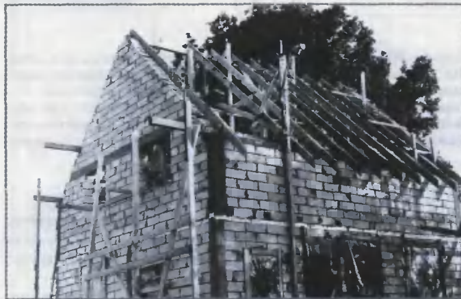
С наступлением весны строителям осталось сделать крышу и обложить стены кирпичом
