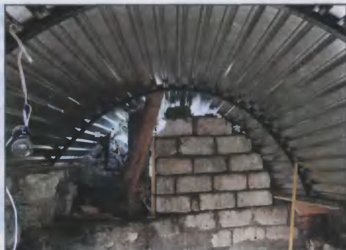
Блоками от старых стен заложили фронтон навеса, оставив пространство для шелковицы
