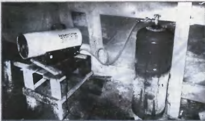
Благодаря газовому теплогенератору температура в «тепляке» не опускалась ниже +15°C даже в самые сильные морозы
