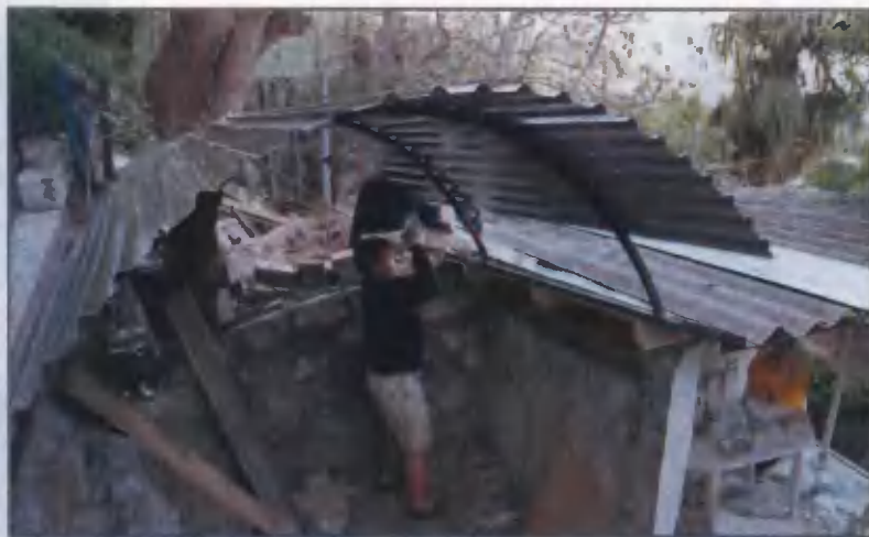
На стыке двух сооружений надо было сделать ендову
